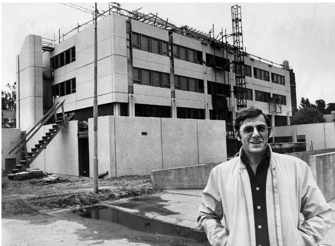
VD Nils Nynäs framför det pågående bygget av Köpmannahuset i början av 1980-talet.
